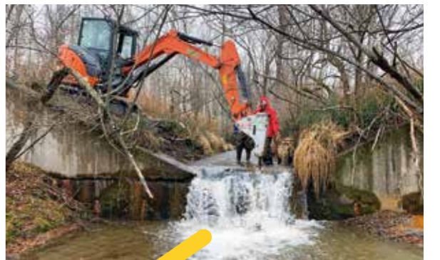
削岩機による落差工の切り下げ作業（市民団体による落差工の掘削は全国初の試み）
