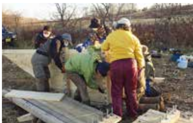
角材を使った魚道の組み立て作業
