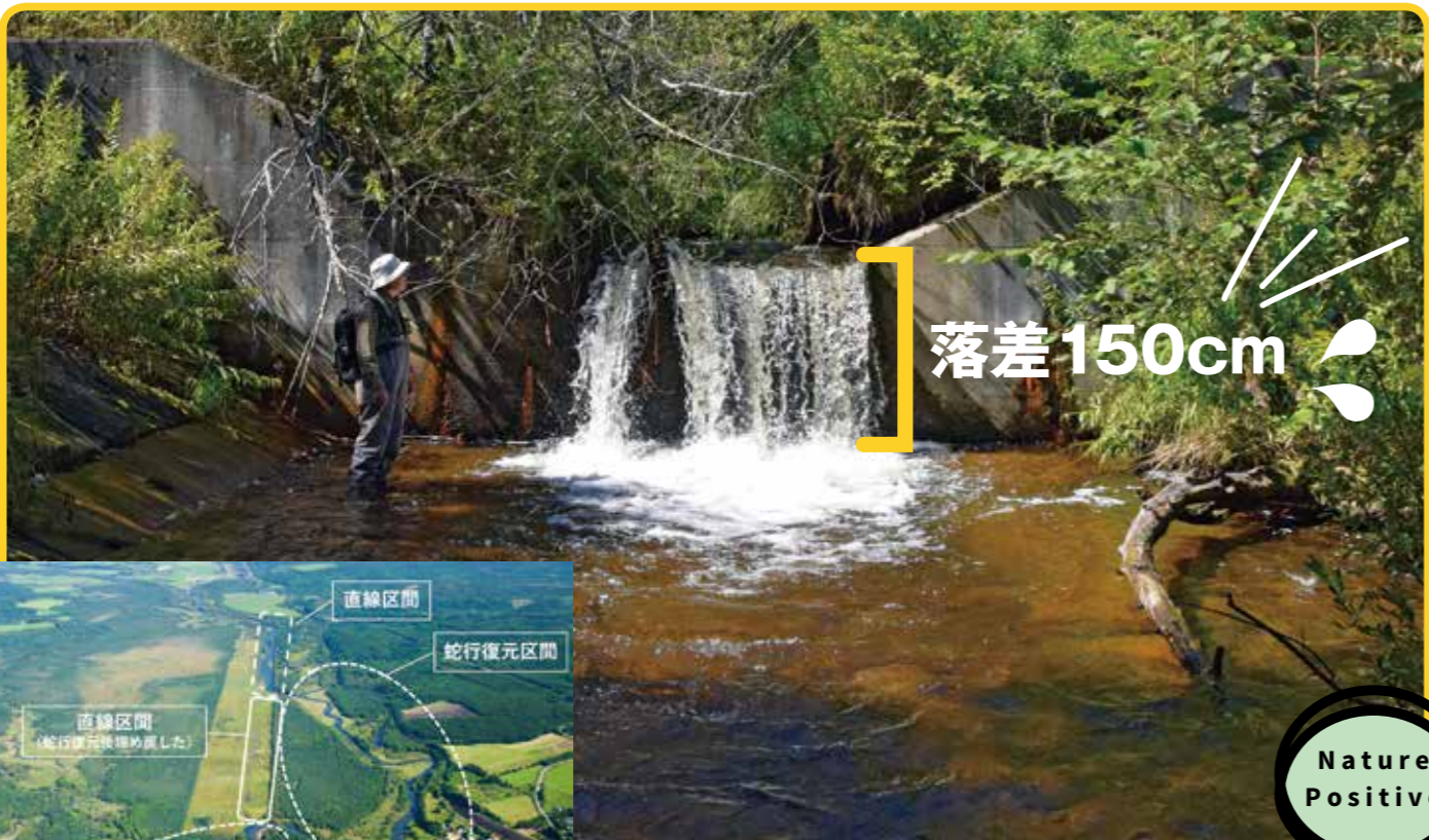
落差工（魚道施工前）。落差が150cm程度あり、魚類の遡上障害になっていた
