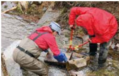
河床ブロックの取り外し作業（撮影：内山到）
