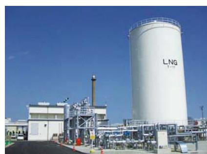
吉田南工厂利用高效热电能量的天然气发电、废热供暖设备。
