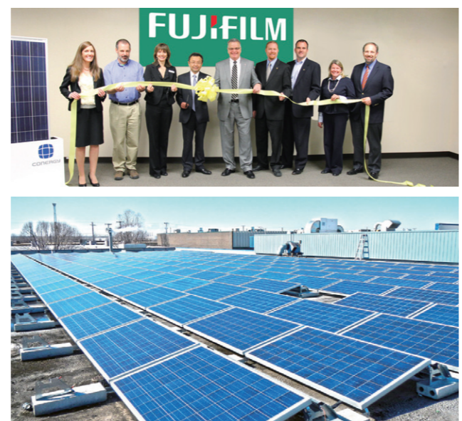
上: 2012年4月20日に行われた落成式 下: 今回設置された太陽光発電設備で年間60,000kWhの発電が可能
