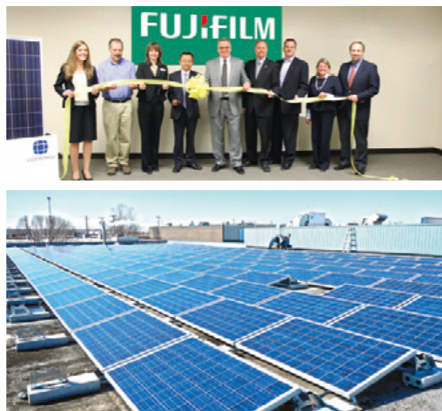
上：2012 年 4 月 20 日举行的竣工仪式 下：这次设置的太阳能光电设备一年大约可发电 60,000kWh
