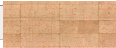
在检查现场，对所检查的桥梁和隧道等的混凝土表面进行拍摄。通过把图像上传到服务器，进入自动检测，可以高精度地检查出宽度0.1mm以上的裂缝(红线部分)。图像的合成和裂缝检查结果的CAD数据制作等也可自动进行
