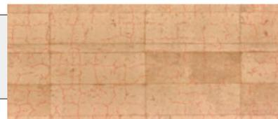
点検現場で検査を行う橋梁やトンネルなどのコンクリート表面を撮影。その画像をサーバーにアップロードすることで、幅0.1mm以上のひび割れの高精度な自動検出結果を得ることが可能(赤線部分)。画像の合成や、ひび割れ検出結果のCADデータの作成なども自動で実施
