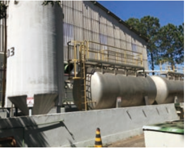
雨水貯蔵設備(FUJIFILM do Brasil Ltda.)
