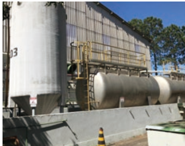
雨水貯蔵設備 (FUJIFILM do Brasil Ltda.)
