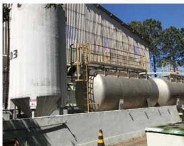
雨水储存设备 (FUJIFILM do Brasil Ltda.)
