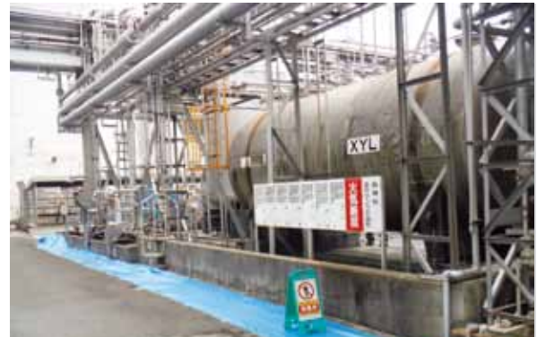
漏洩リスクの高い老朽配管撤去の様子
