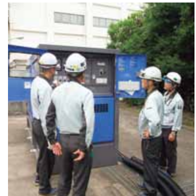
非常用発電機作動訓練
