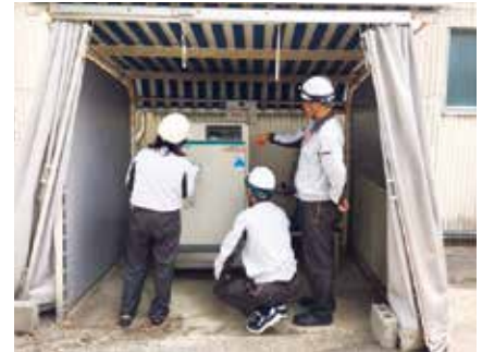
騒音発生源の調査の様子
